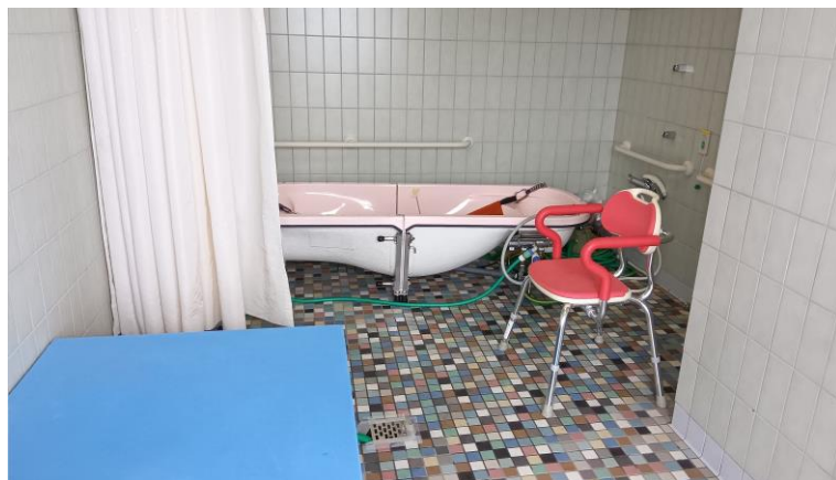
▲シャワー室の中に浴槽を常設し、シャワー栓にホースを接続して直接給湯
