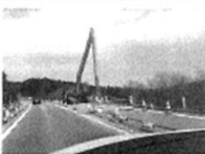
▲道路の整備工事が進む
