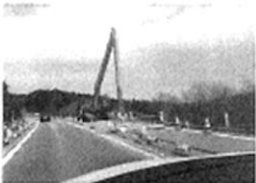
▲道路の整備工事が進む
